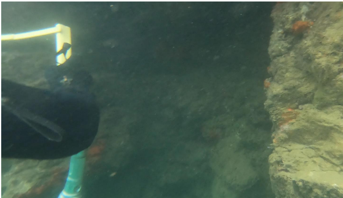
Εικόνα 2.10 Έξαλη και ύφαλη εσοχή διαστάσεων 2.00 x 2.00 x 1.15 (υ x π x β) στην προσήνεμη πλευρά του προστατευτικού τοιχίου [Θέση: Θ5]
