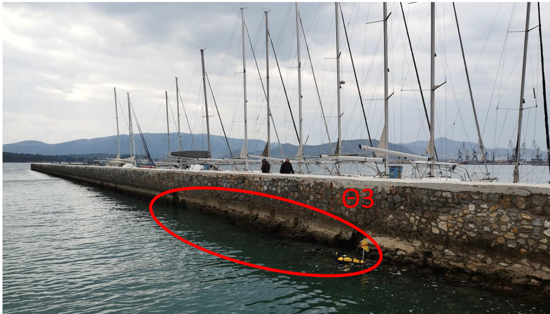
Εικόνα 2.8 Έξαλη και ύφαλη εσοχή διαστάσεων 0.80 x 3.00 x1 .35 (υ x π x β) στην προσήνεμη πλευρά του προστατευτικού τοιχίου [Θέση: Θ3]
