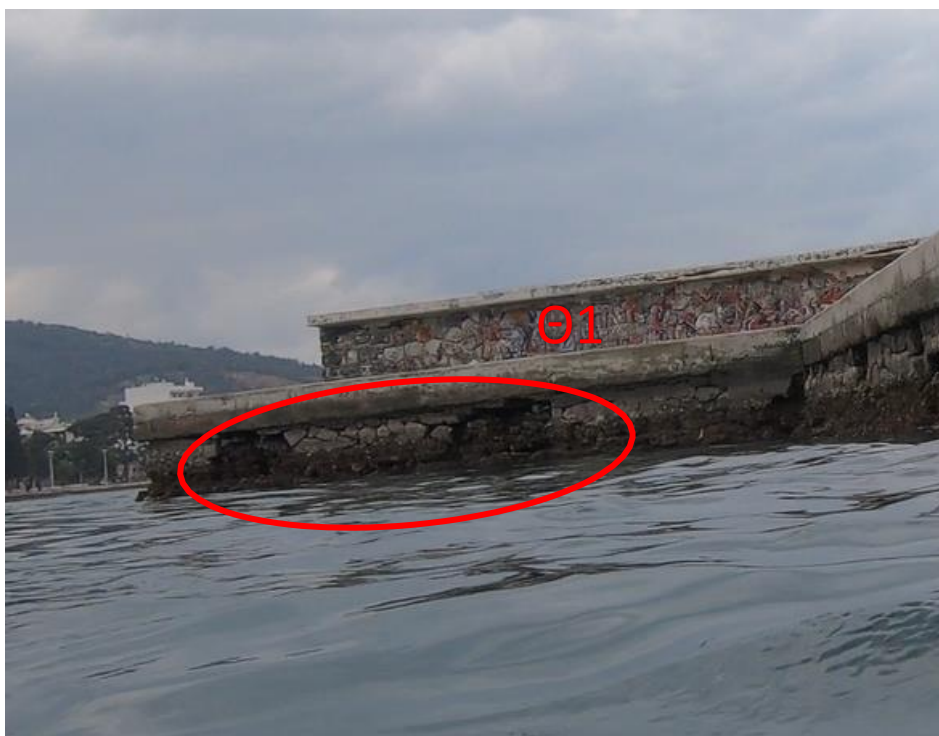
Εικόνα 2.6 Έξαλες εσοχές [Θέση:Θ1]
