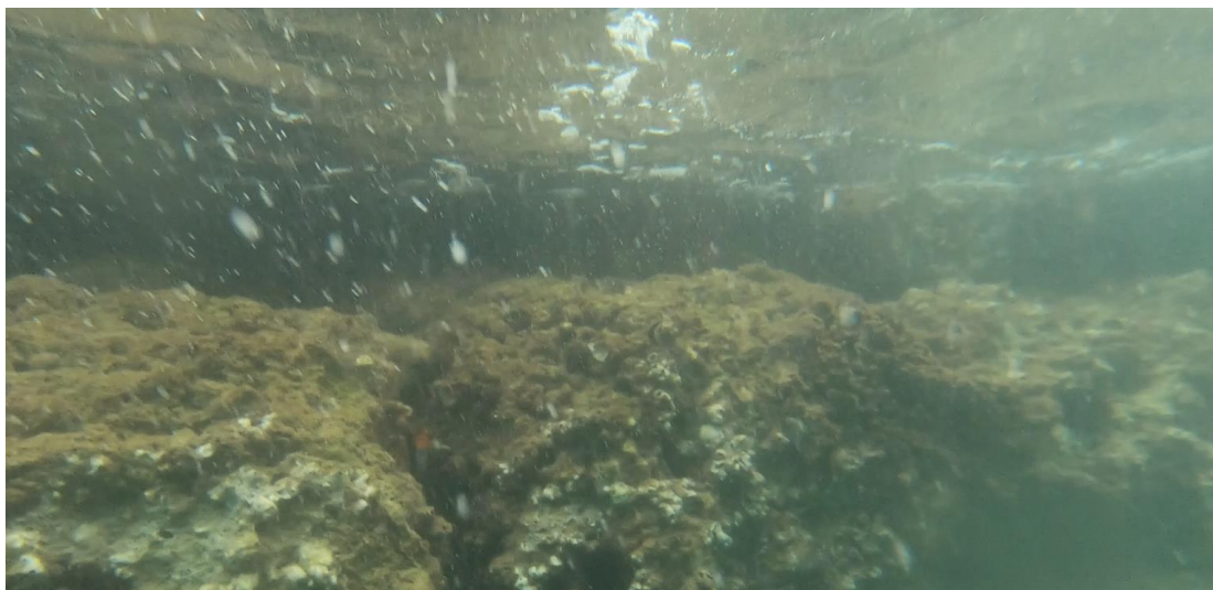
Εικόνα 2.9 Έξαλη και ύφαλη εσοχή στην προσήνεμη πλευρά του προστατευτικού τοιχίου [Θέση: Θ4]
