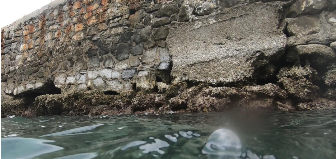
Εικόνα 2.14 Έξαλη εσοχή στην προσήνεμη πλευρά του προστατευτικού τοιχίου [Θέση: Θ9]
