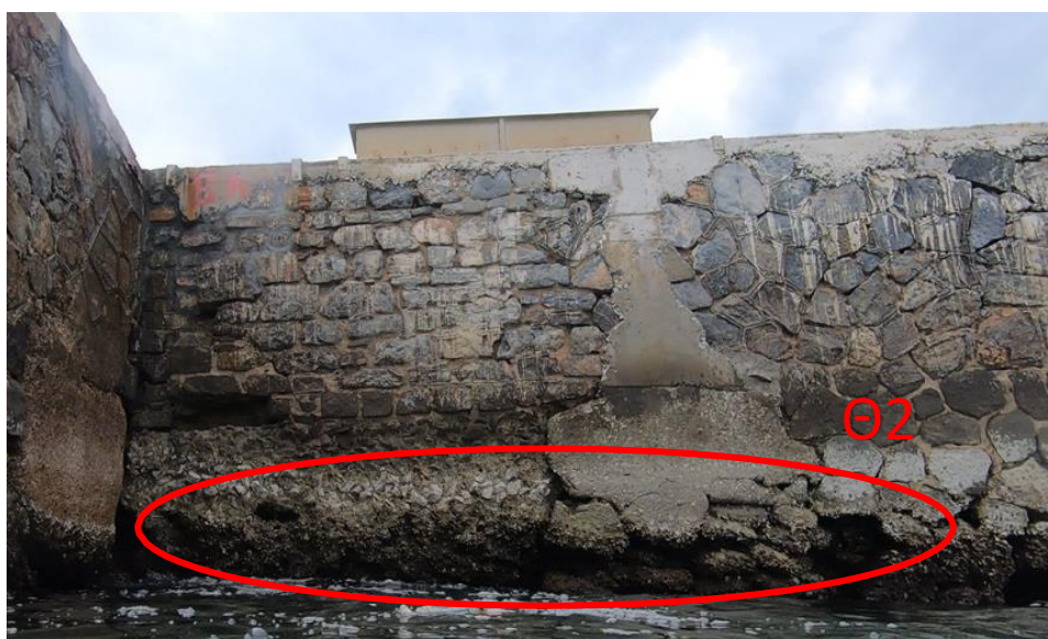
Εικόνα 2.7 Έξαλες εσοχές [Θέση: Θ2]
