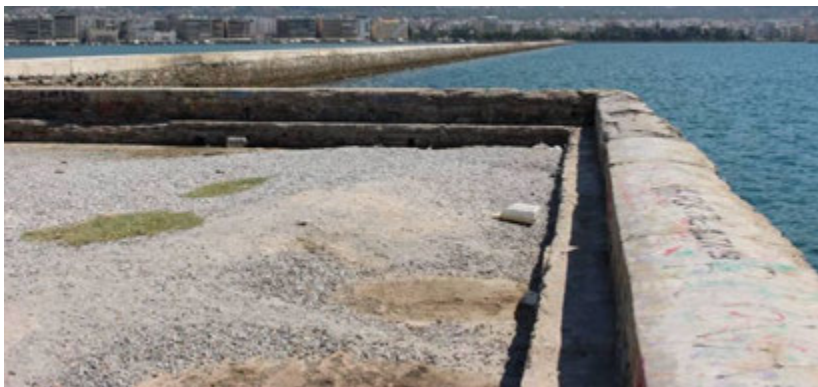
Φωτ. 2-15 Διαστρωθέν αμμοχάλικο στην χερσαία ζώνη του ακρομωλίου
