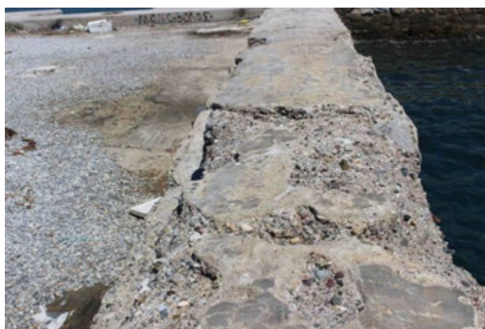
Φωτ. 2-16 Ρηγματωμένες επιστρώσεις προς την περιοχή συναρμογής με προσήνεμο μώλο.
